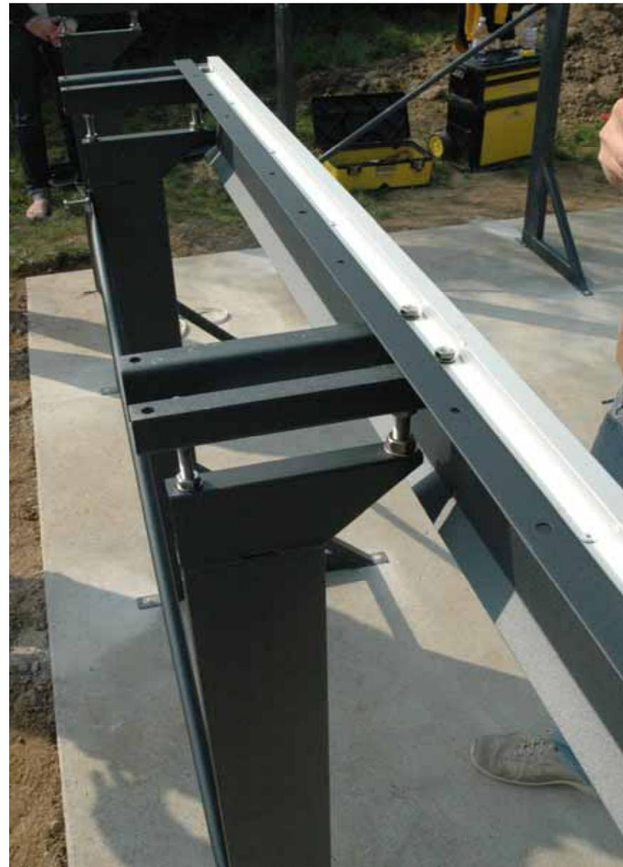
Montare le lamiere C avvitando i bulloni N sui supporti B come da figura prestando attenzione ad allineare le stesse in modo da ottenere un profilo continuo ovvero senza gradini tra un pezzo e quello successivo.
