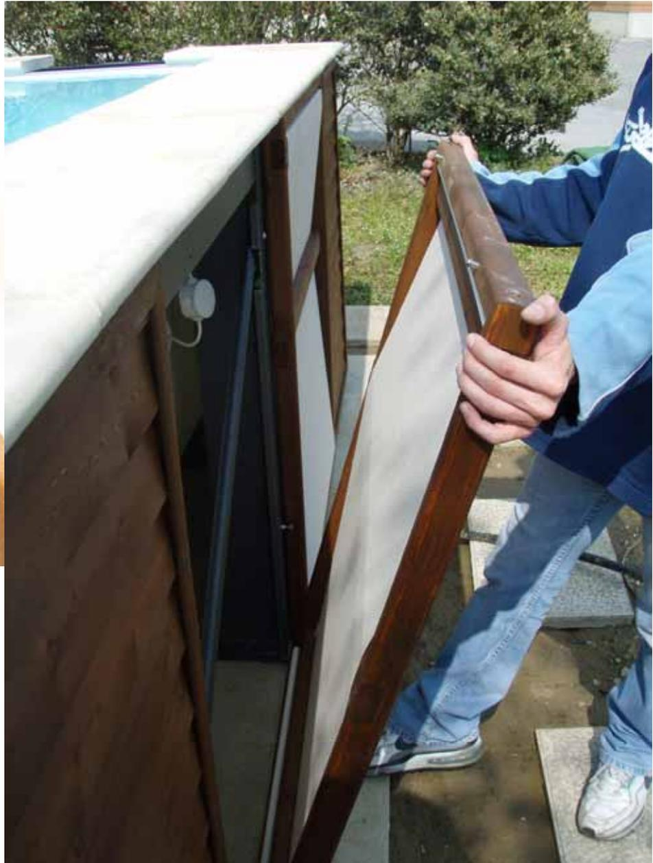
Agganciare i pannelli inserendo prima il perno di base nell'asola posta sul piede della lamiera di supporto e poi appoggiando le 2 viti superiori del pannello nelle apposite scanalature presenti sul profilo superiore esterno E
