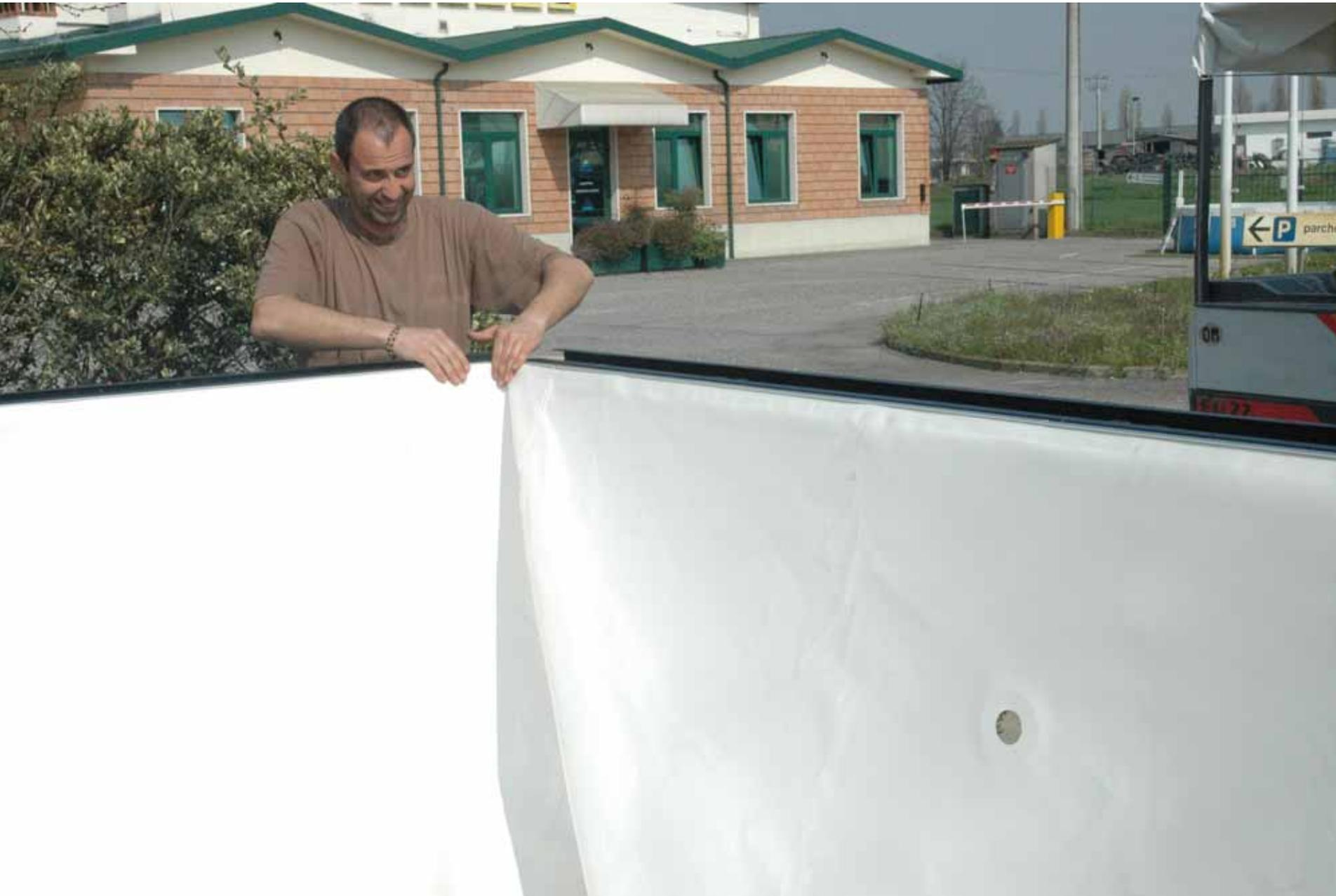
Iniziando dagli angoli inserire il cordino in PVC grigio nel profilo di alluminio al disopra del bordo del telo vasca aiutandosi con un cacciavite per aumentare lo spazio di inserimento.
