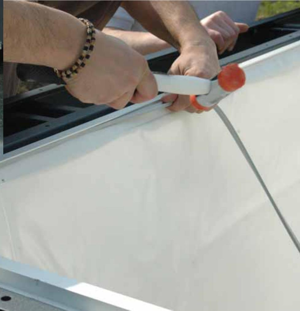
Iniziando dagli angoli inserire il cordino in PVC grigio nel profilo di alluminio al disopra del bordo del telo vasca aiutandosi con un cacciavite per aumentare lo spazio di inserimento.
