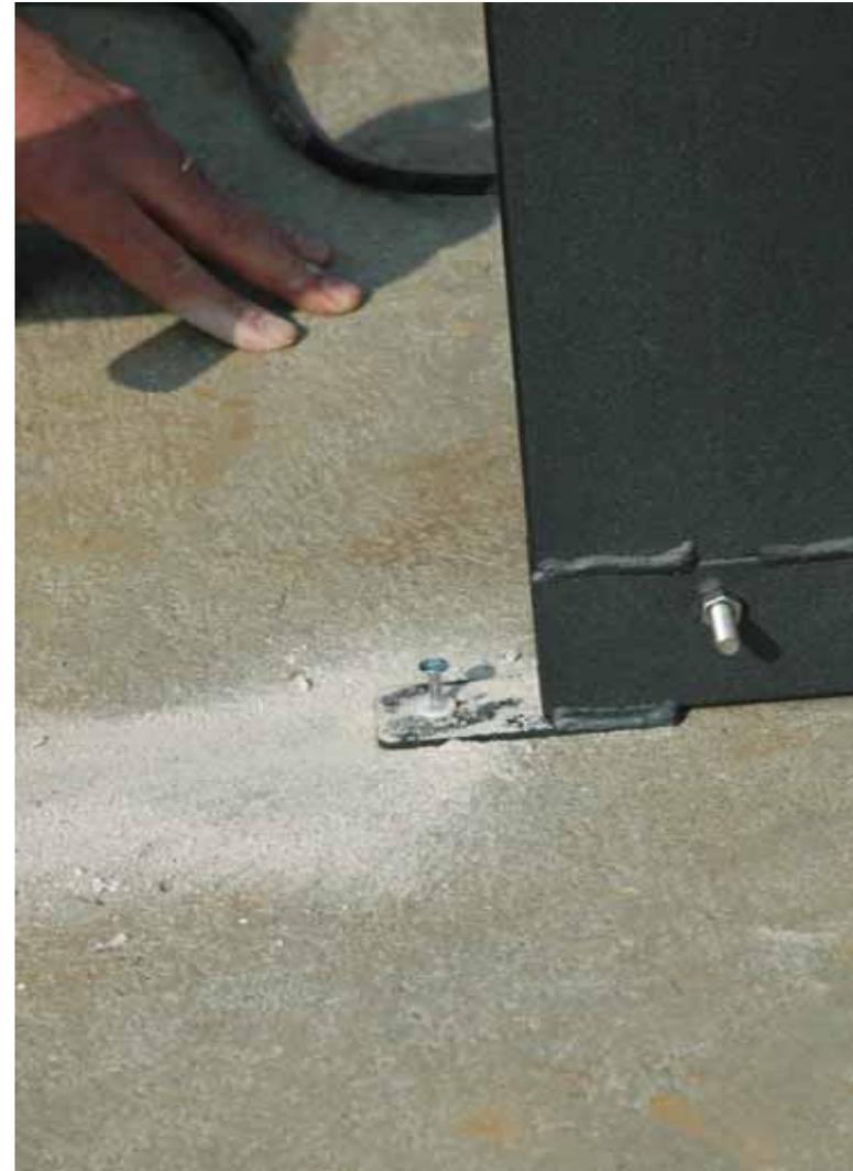
Tassellare le gambe A utilizzando il trapano a percussione per cemento armato con una adeguata punta da 8 mm di diametro.
