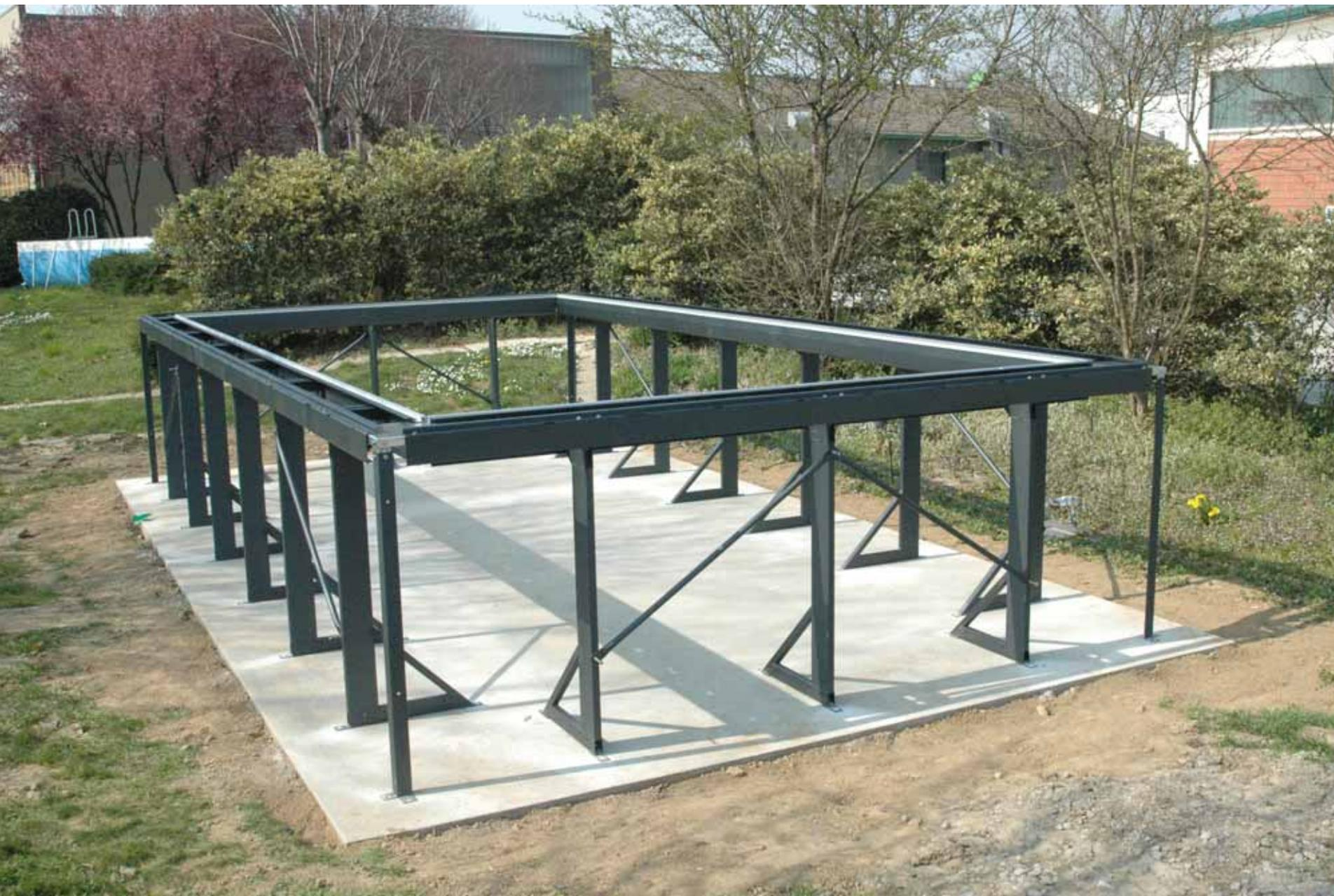
Togliere tutto il materiale non montato e pulire completamente la piazzola in cemento da polvere, sassolini e imballaggi in modo da evitare che questi possano rimanere accidentalmente sotto il telo della vasca con il pericolo di creare potenziali punti di foratura.
