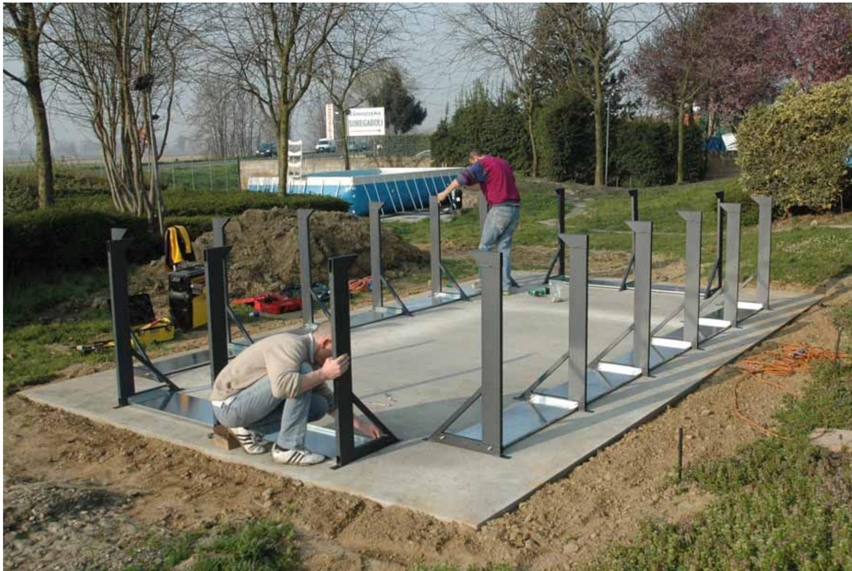
Tassellare le gambe A utilizzando il trapano a percussione per cemento armato con una adeguata punta da 8 mm di diametro.
