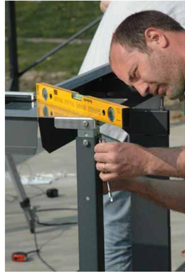
Effettuare l'allineamento interno dei 4 lati definiti dalle lamiera C tirando un filo da muratore in modo da vedere la linea retta da seguire(vedi foto) Agire sui profili B facendoli scorrere sulle loro asole fino ad ottenere il perfetto allineamento interno. A questo punto serrare completamente i dadi facendo attenzione a non variare i livelli precedentemente fissati.
