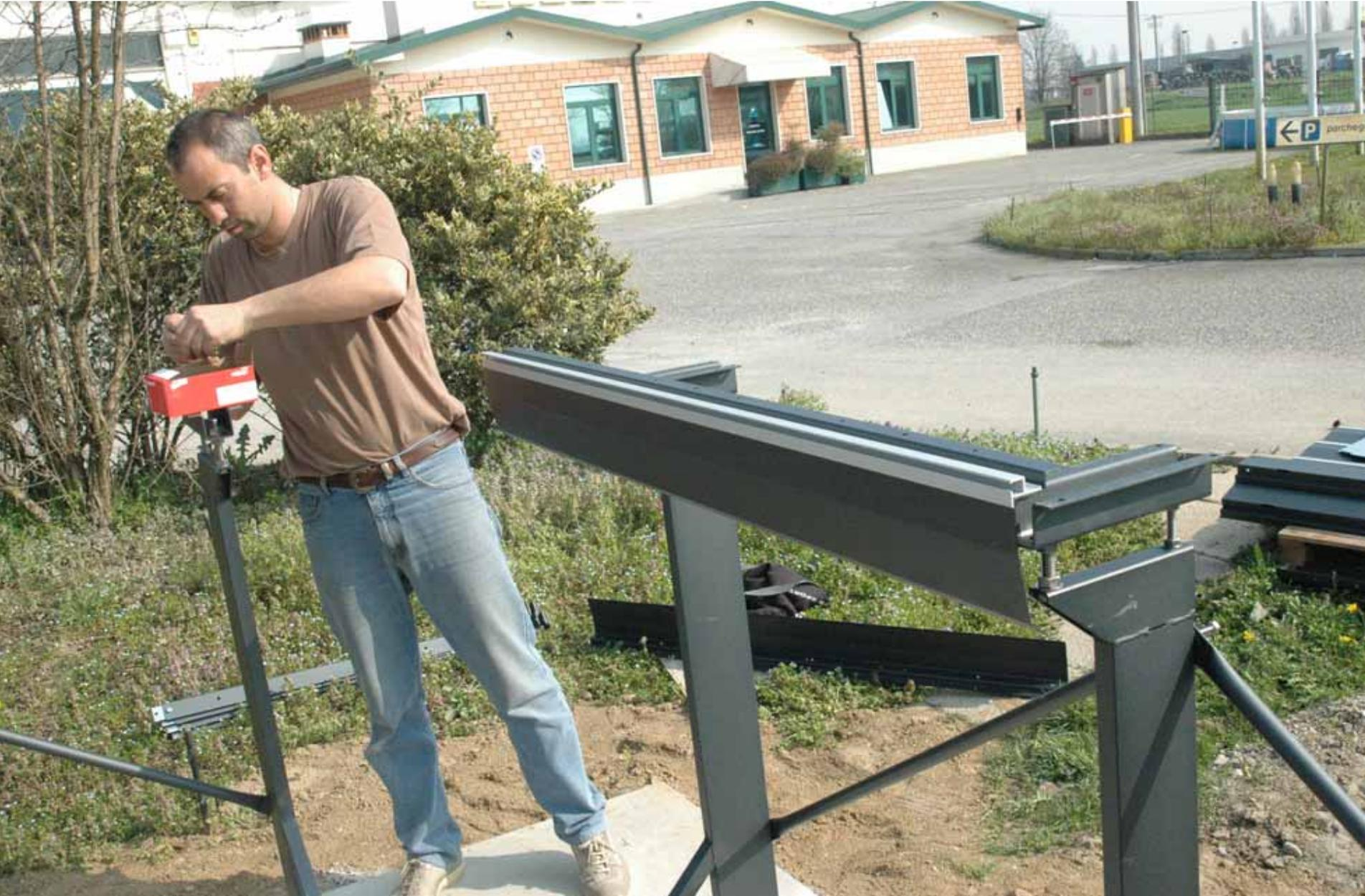
Montare le lamiere C avvitando i bulloni N sui supporti B come da figura prestando attenzione ad allineare le stesse in modo da ottenere un profilo continuo ovvero senza gradini tra un pezzo e quello successivo.
